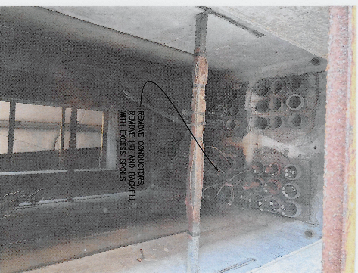
06 9'x5'x6' VAULT INSIDE METAL SHED SCALE: N.T.S.
